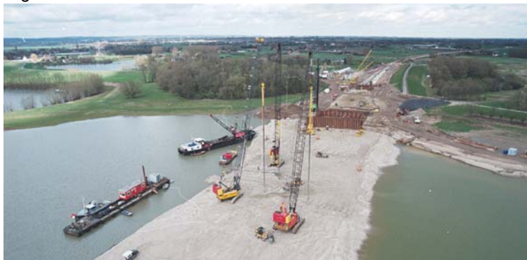
▲ Overzicht van Kandiadam met 3 rüttelinstallaties. Op de achtergrond de ontvangstput
