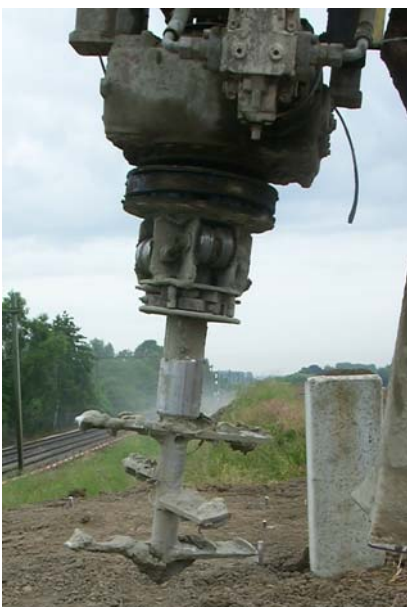
▲ detail van de boorkop
