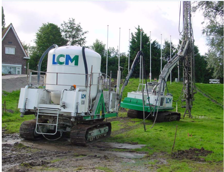
▲ Droge Mixed-In-Place in uitvoering
