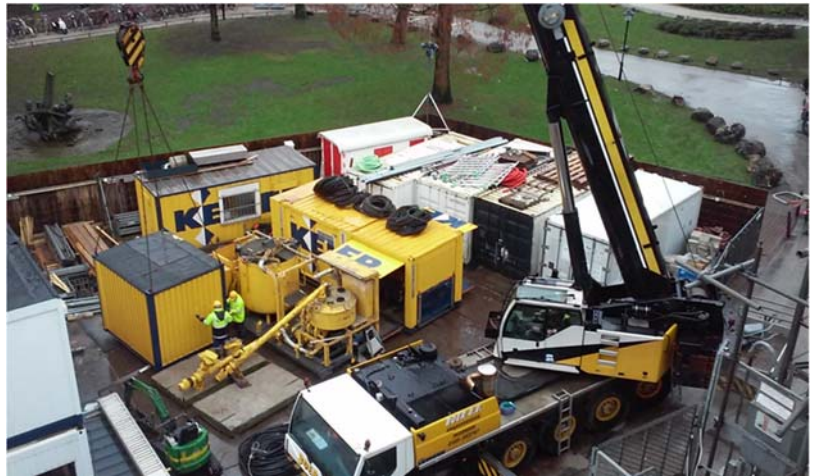
▲ Ook de bouwplaats was beperkt in ruimte
