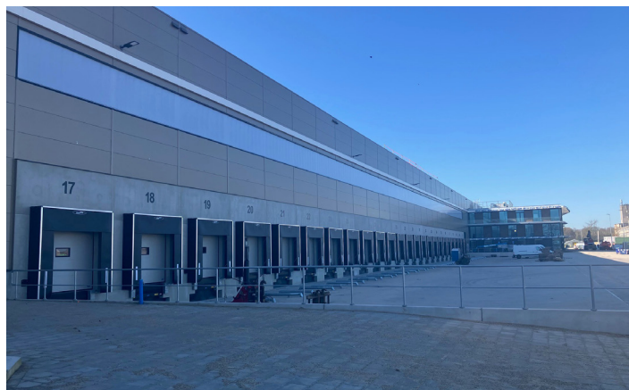
Boven: Gezamenlijk beschikken de warehouses over 79 loading docks.
